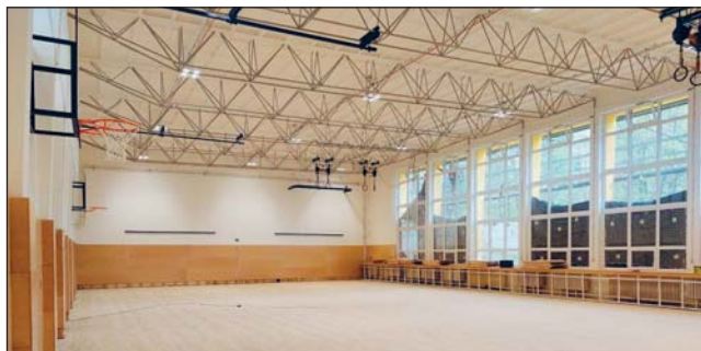
GENERÁLNÍ REKONSTRUKCE tělocvičny ZŠ Gen. Janka se blíží do finále. Opravy financované z rozpočtu obvodu, města a z dotací probíhají podle plánu a tělocvična bude brzo k dispozici dětem.
